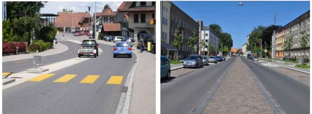
Abb. 16 Beispiele für multifunktionale Mittelstreifen
